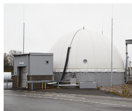
Rågasen har en 65-procentig metanhalt och resten är koldioxid. Den förs ut till en gasklocka och renas sen till 97-procentig metangas till tankstationen.
